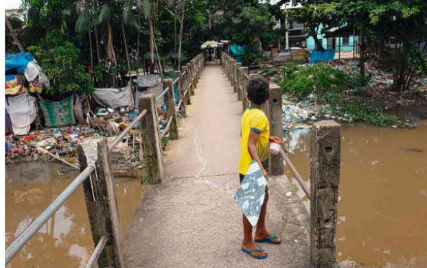
Canal São Joaquim, em região de Belém onde as obras estão abandonadas. Folhapress
