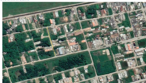
Rua R2 – Loteamento Recanto do Sol Execução: Joanne Torralba Gimenez Lemos Foto: Imagem 2021
