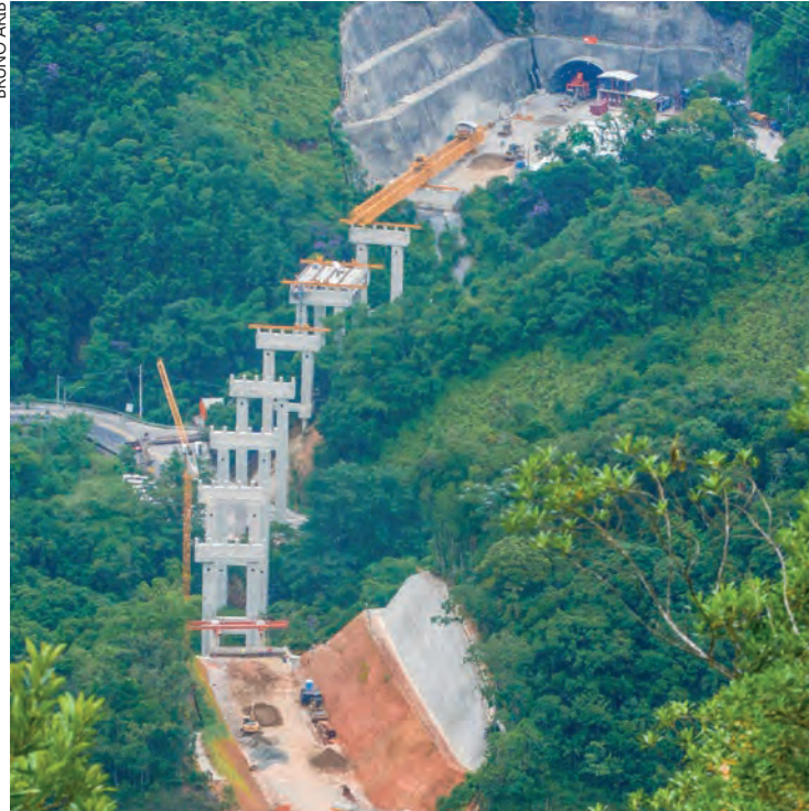
A retomada das obras vai gerar 2 mil postos de trabalho
