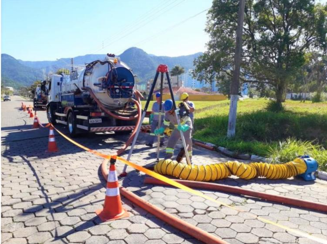
Sabesp executa limpeza preventiva de redes em Caraguatatuba. (Foto: Divulgação)
